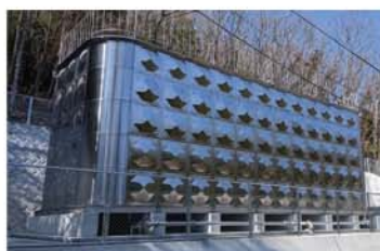
完成した石生配水池
