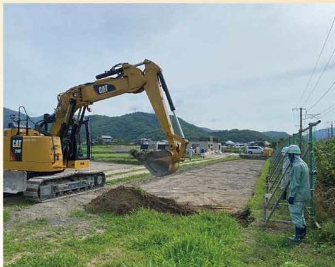
▲土の様子を見極めながら掘る深さを指示します
