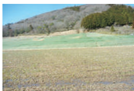
日笠地区の防草シート設置状況
