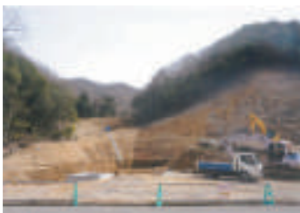
工事が進む残土処分場
