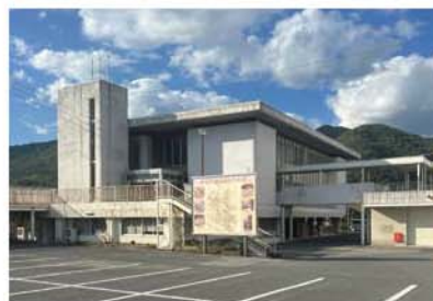
使用も少なく 改修もされない 佐伯庁舎分館
