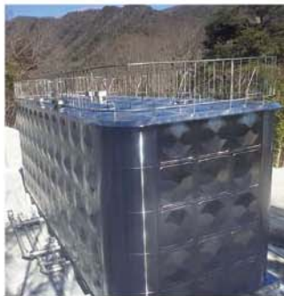
3月に完成した石生配水池。 今後も大型の設備投資が 予想される水道事業。
