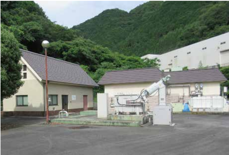
農業集落排水処理場（塩田浄化センター）
