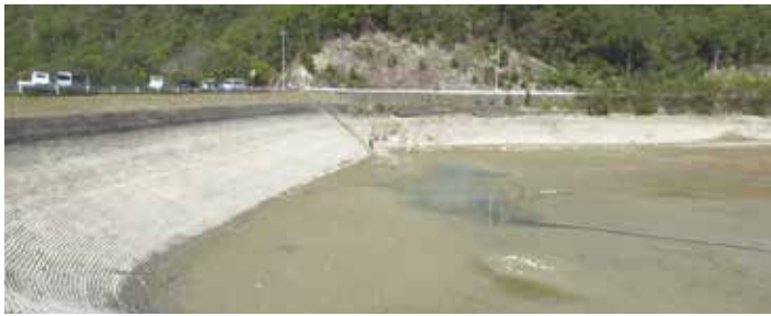
稲坪池の点検作業
