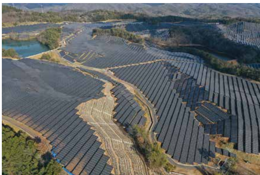
備前ゴルフ跡地に設置が進んでいる太陽光発電設備
