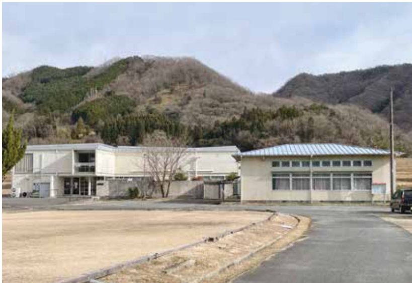
解体が始まる日笠地区公民館
