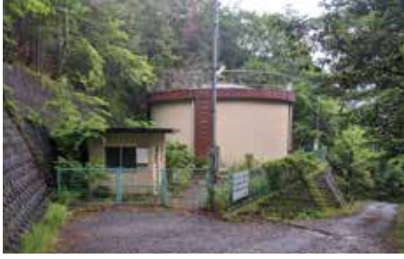
石生配水池(田原上地内)
