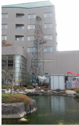
平成29年に行われた汲み上げポンプ工事の様子
