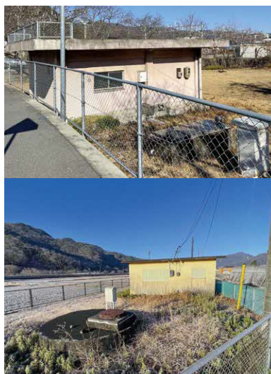
目標値以下ではあるが、PFASが検出された南部水源地(上)と吉田水源地(下)
