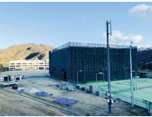
長寿命化に向けて改修工事が行われている佐伯中学校体育館
