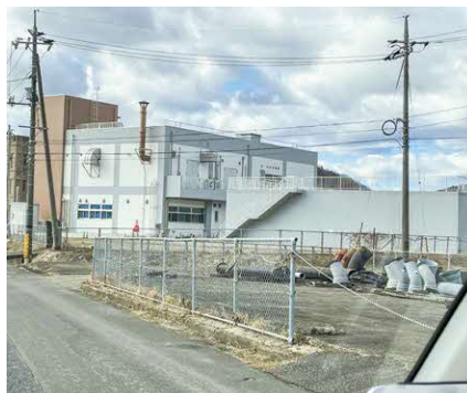
和気町への水の供給が検討されている備前市坂根浄水場
