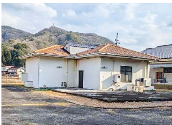
廃止を検討している父井原農業集落排水処理場
