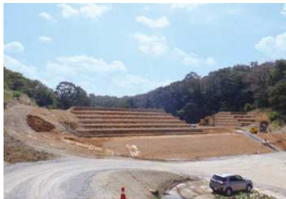
全面改修中の長谷池
