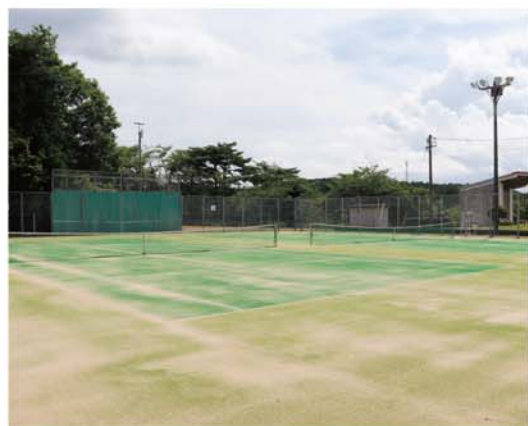
改修されたロマンツエのテニスコート
