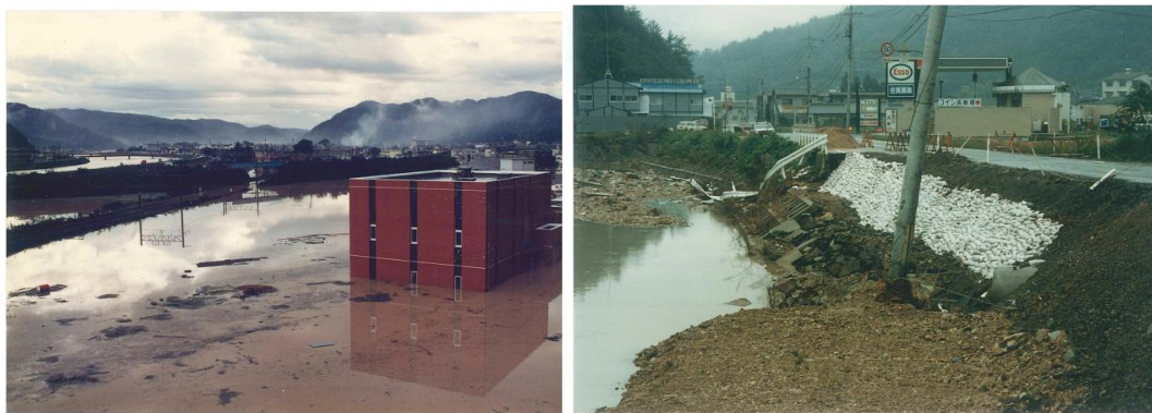
図 1－1．平成 2 年台風 19 号による和気町被災状況の様子
