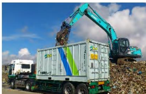
仮置場での海上コンテナへの積込
