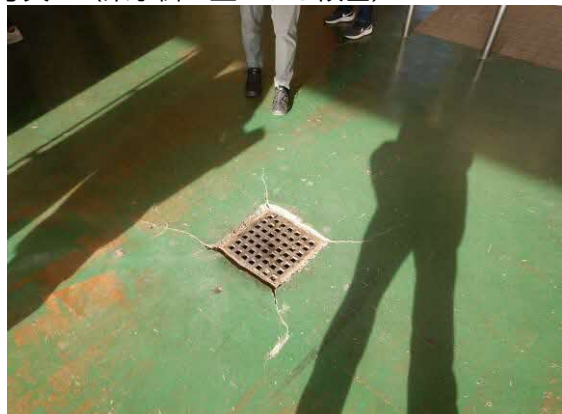
写真 4（集水桝の蓋による段差）
